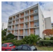
Résidence Ronceval Audit énergétique et DTG : 234 Lots
