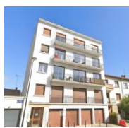
Résidence Louis Barthou Audit énergétique et DTG : 4 Lots
