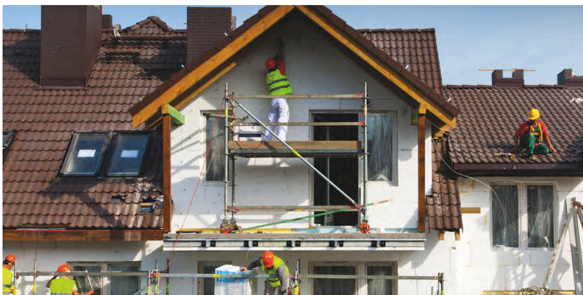
Rénovation globale d'une maison en Hauts-de-France
